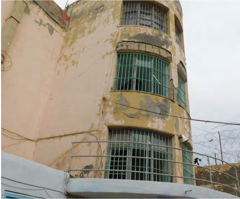
Κατάστημα Κράτησης Αλικαρνασσοῦ - αυτοψία 16 & 17/11/21
