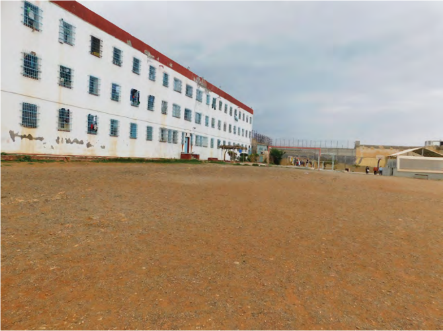
Κατάστημα Κράτησης Αλικαρνασσού - αυτοψία 16 & 17/11/21
